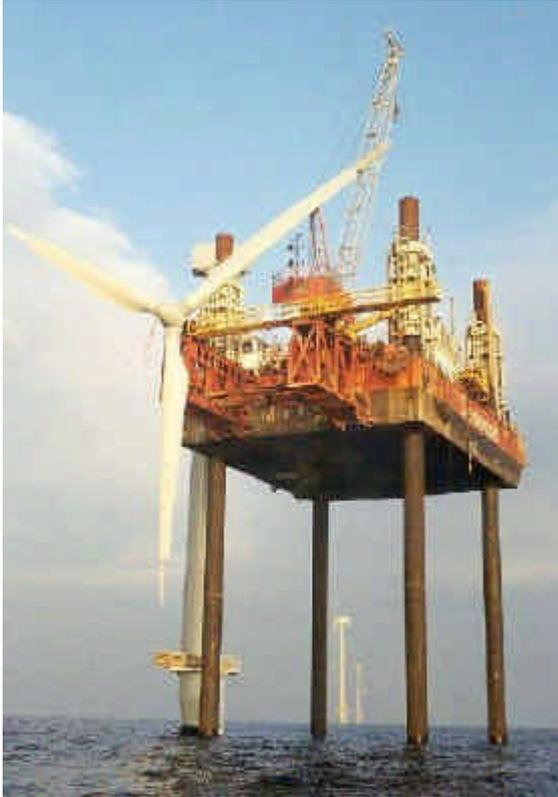
Abb (10): Jack – Up - Plattform im Bockstigen Windpark mit Monopile-Gründung [17]
